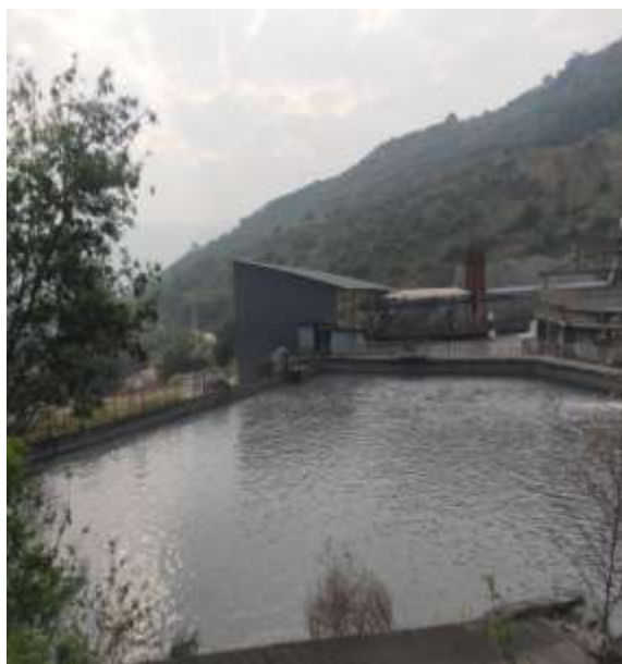
图 4-4 水选厂废水沉淀池
