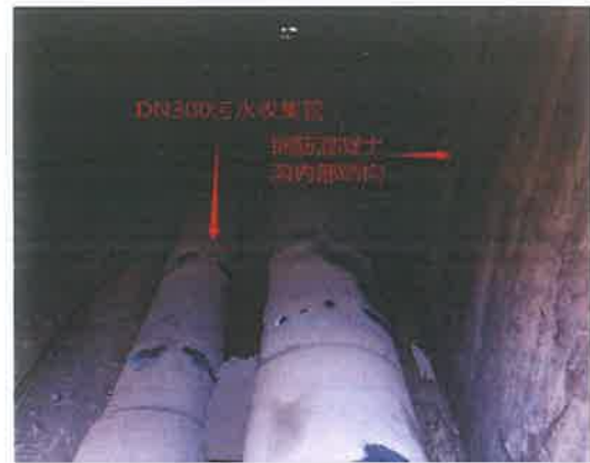
地埋设段内部结构
