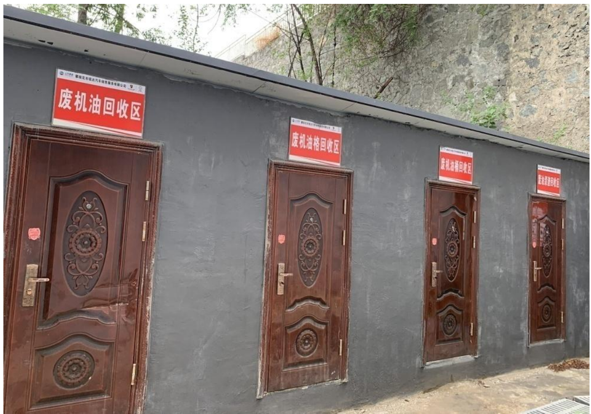
危废暂存间 图 3-11
