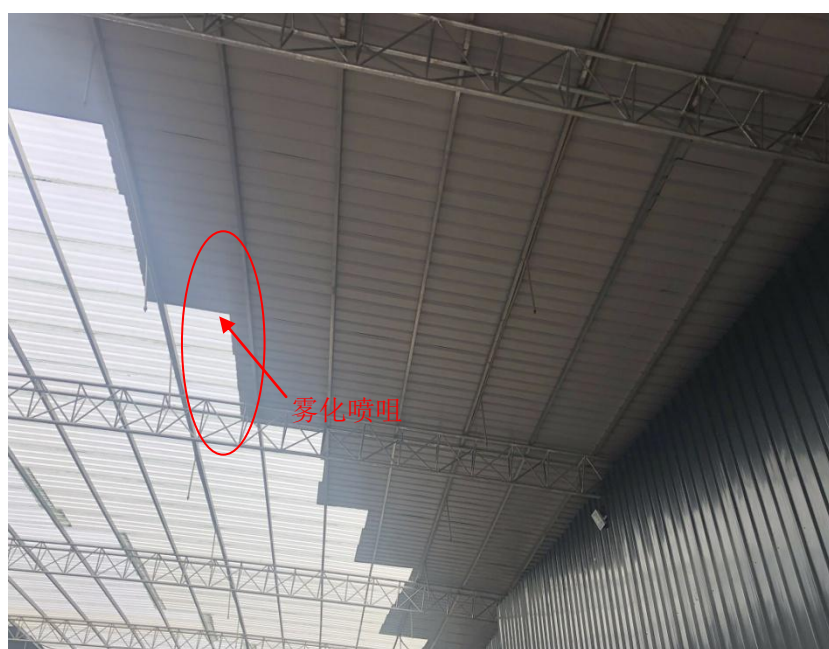
图 3-2 原料堆场现状
